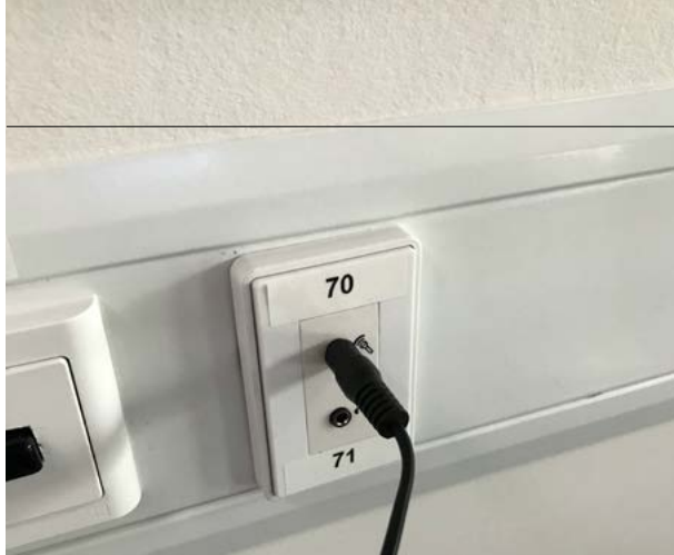
Billede 6.4.3 (th) og 6.4.4 (tv): På billedet til venstre ses lydstikkene. Billedet til højre viser, hvordan der (fast) er et jackstick (forsyner musiktablettet ved arbejdsstationen med en lydport), som hænger løst og uhensigtsmæssigt mellem stikkene og arbejdsstationen.
