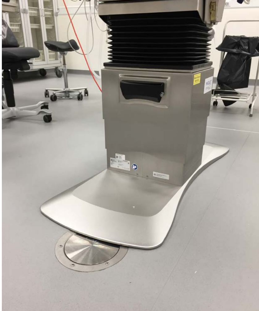
Billede 5.2.2 viser gulvafløbet, der er placeret ind under operationslejets fod.
