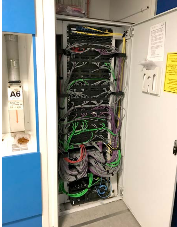
Billede 5.8.5 viser et krydsfelt i rette dimensioner, som er installeret med baggrund i den regionale standard. Dog skal det bemærkes at adgangsforholdene her er suboptimale, da der ikke er adgang fra siden.
