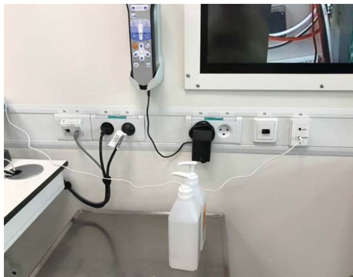
Billede 6.4.3 (th) og 6.4.4 (tv): På billedet til venstre ses lydstikkene. Billedet til højre viser, hvordan der (fast) er et jackstick (forsyner musiktablettet ved arbejdsstationen med en lydport), som hænger løst og uhensigtsmæssigt mellem stikkene og arbejdsstationen.
