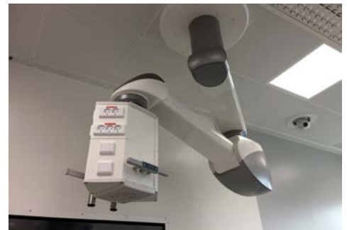
Billede 5.6.5 viser "let forsyningssøjle".
