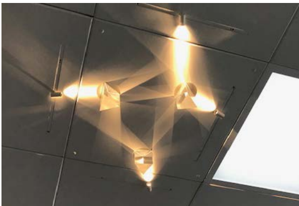
Billede 7.1.9 og 7.1.10 – Her ses et før (tv.) og efter (th.) billede af prismelyset ift. justeringen med farvet folie. Hver prisme har fået lagt én farve folie på én side.
