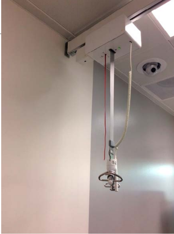
Billede 5.5.1 – Skinne med løfte- og bremsemodul
