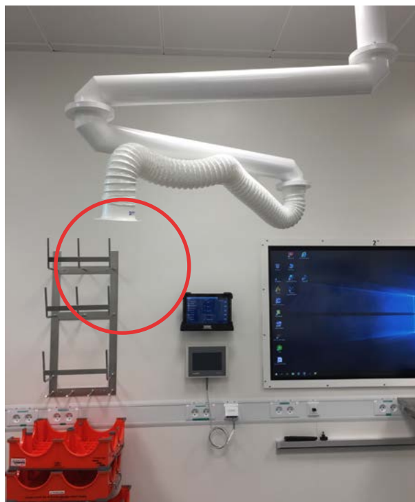
Billede 6.2.2 viser punktudsug uden kildefilter.
