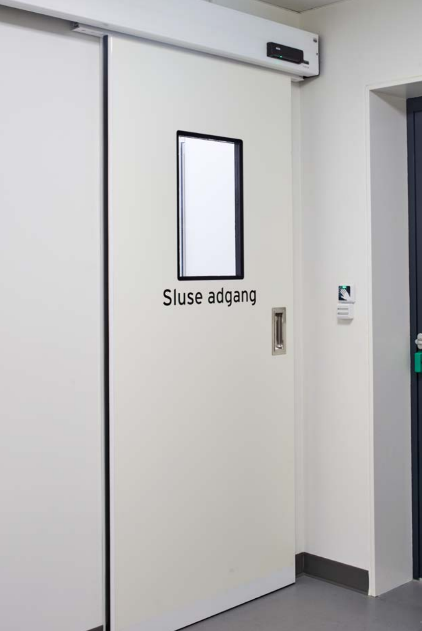
Billede 5.7.4 viser slusen fra gangsidens med skydedør.
