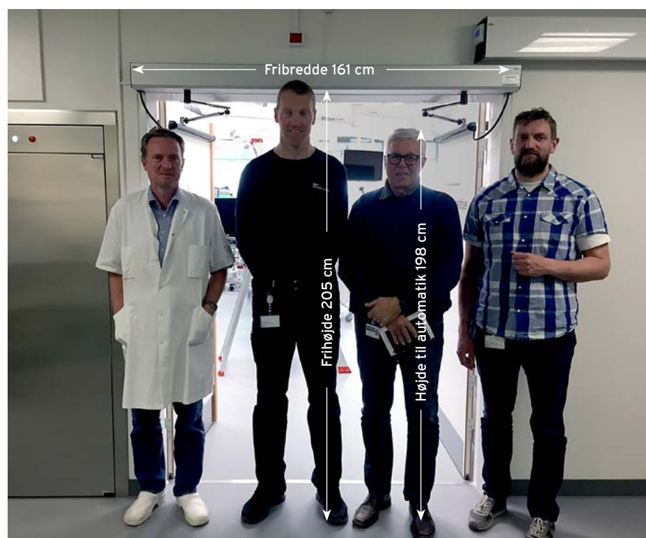
Billede 5.7.3 – Billedet illustrerer dørens frihøjde set ift. servicepersonale, der servicerer operationsstuen. Højeste mand er 206 cm.
