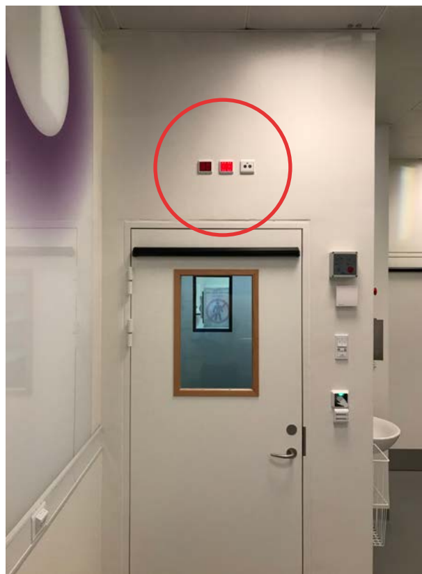
Billede 6.4.5 viser røde lampeindikatorer over slusedør inde på operationsstuen.
