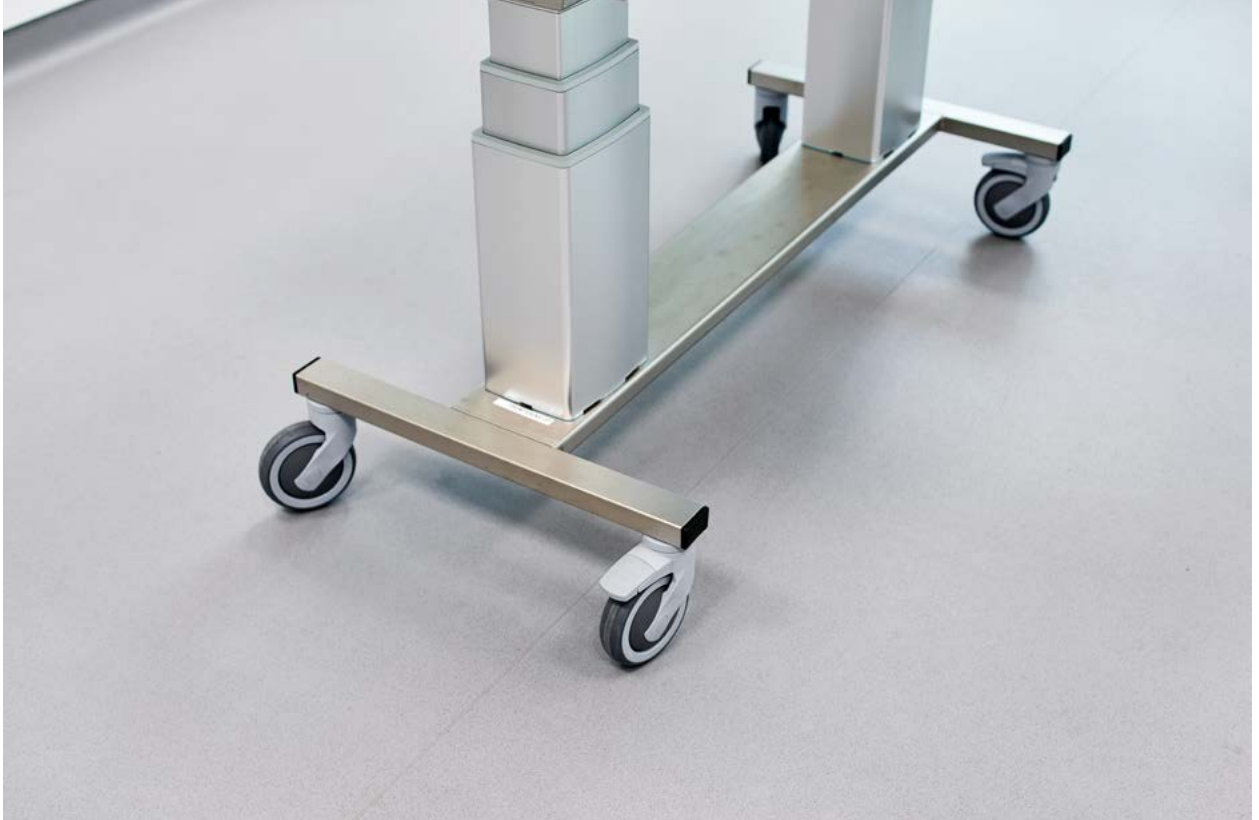
Billede 5.2.1 viser valgte gulvbelægning (vinyl, R9, Altro Safety WM 2009P).
