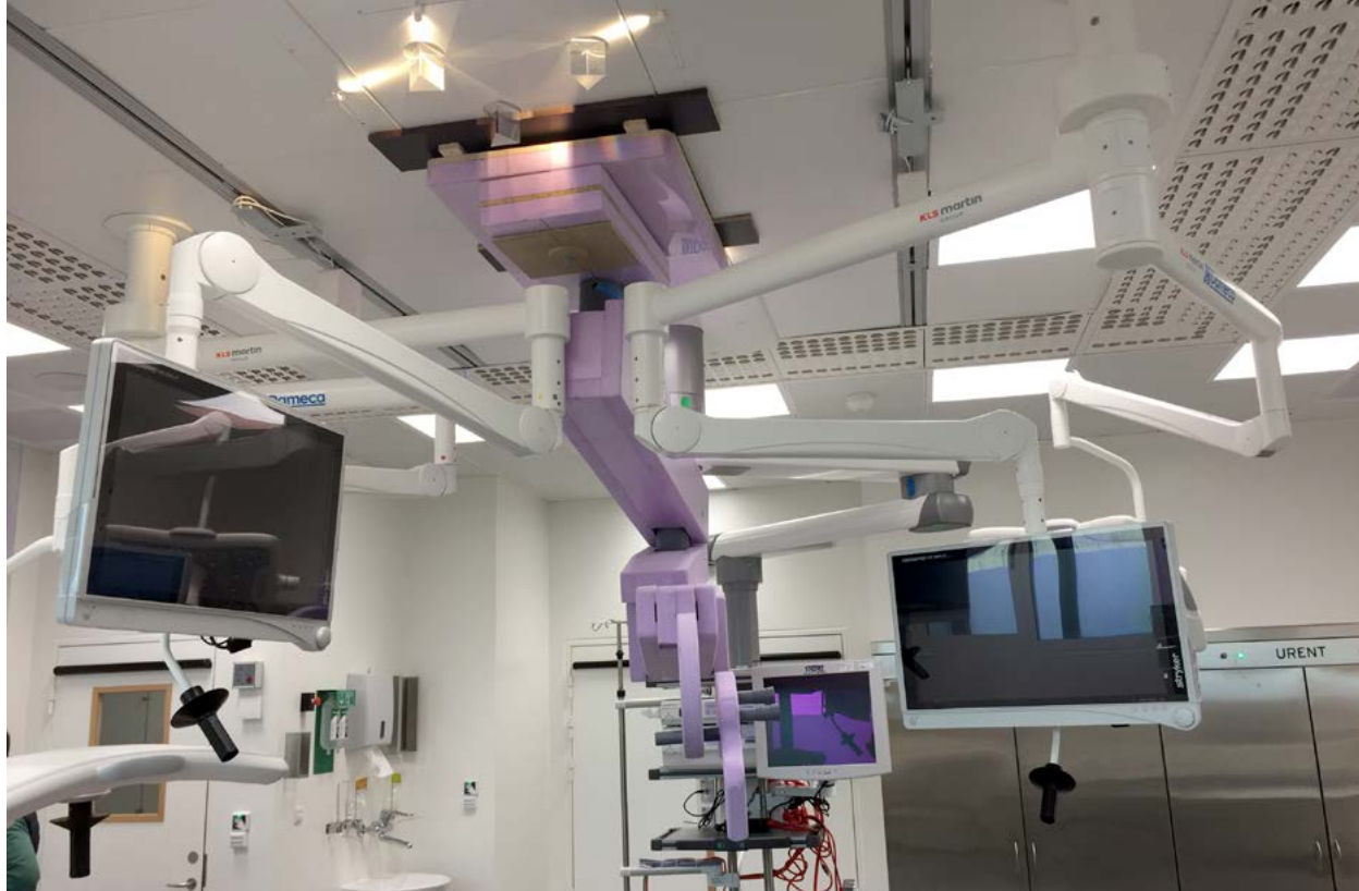
Billede 5.6.2 viser installationer i loftet fx prismer og skinner til loftlift. Her ses hvordan armene fra monitorer kommer for tæt på mikroskopet.
