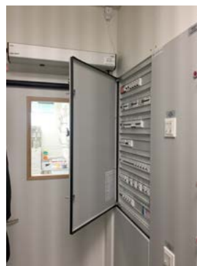
Billede 5.8.10 – Lågen til el-tavle kan ikke åbnes helt grundet dørautomatikken.
