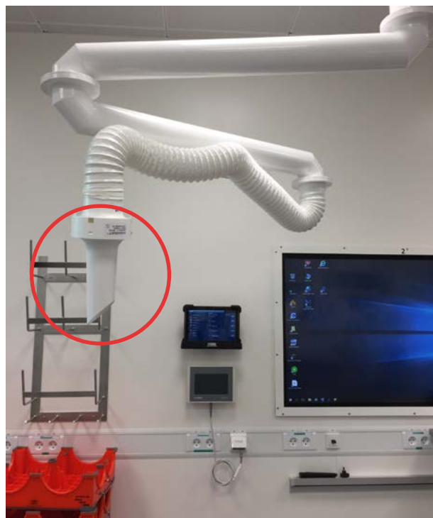
Billede 6.2.1 viser punktudsug med kildefilter med filtreringsgrad på 99,97 % (yderste del af sug).
