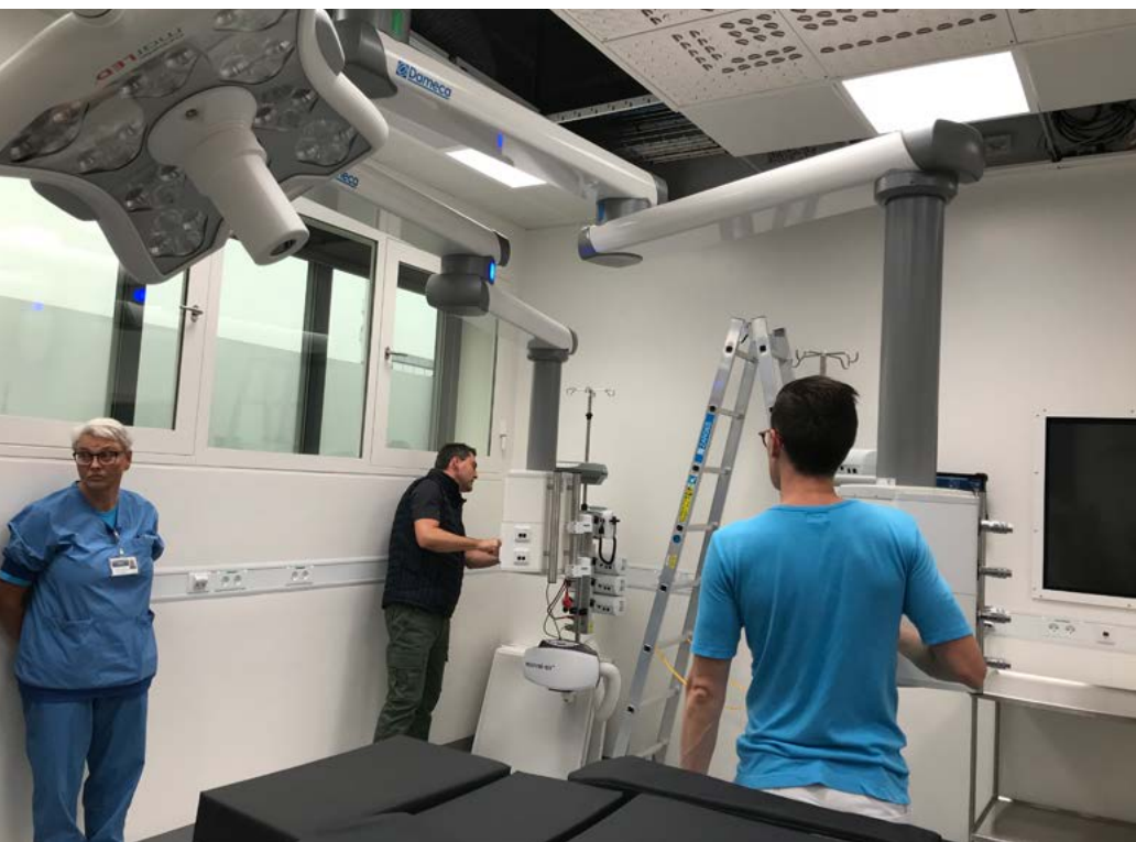
Billede 5.4.2 – Billede fra simuleringstest med anæstesen, hvor der blev afprøvet forskellige positioner for anæstesisøjlerne.
