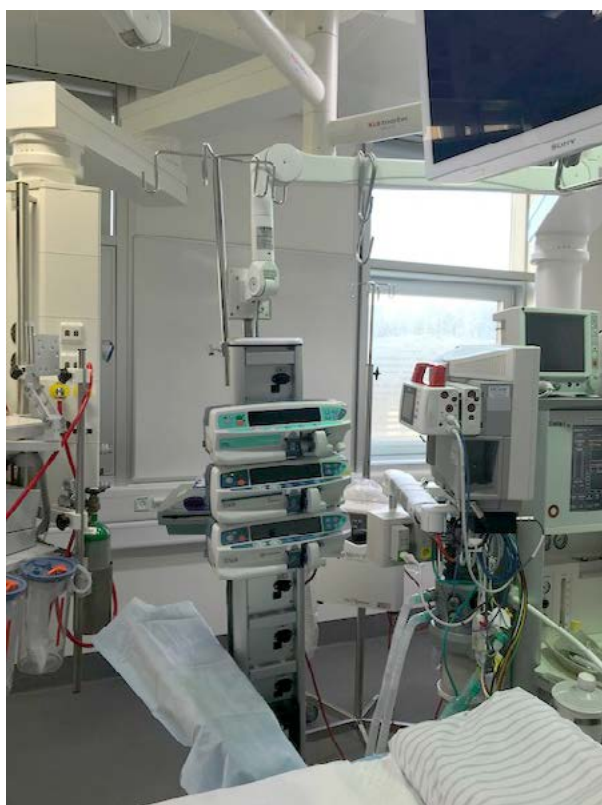
Billede 5.4.7 – Billede af let søjlearm med dockingstation på afdeling T's hybridstue.
